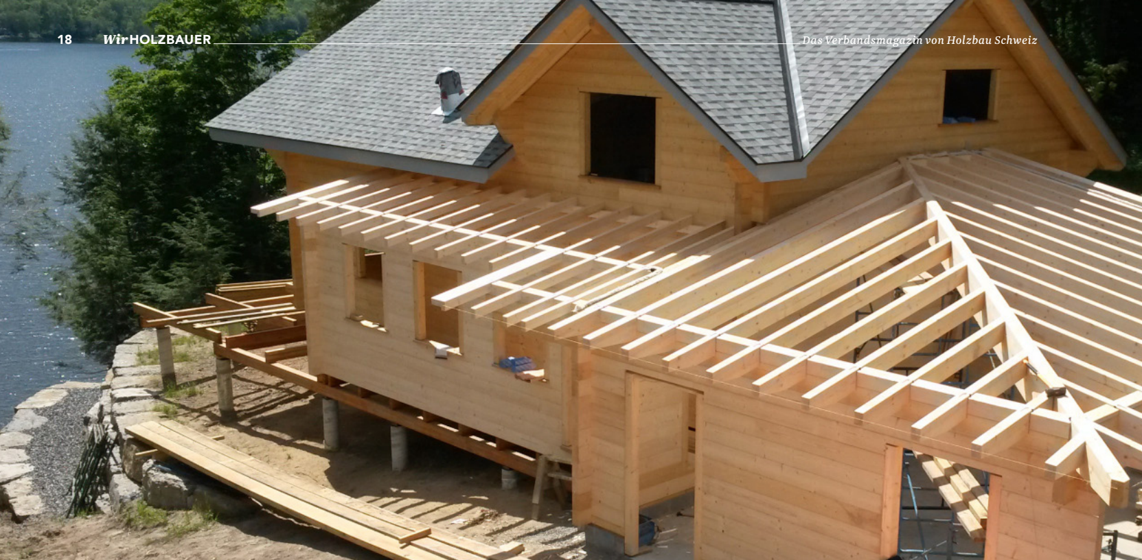
Die Länge des Schiffcontainers hat das Mass des Hauses bestimmt. Die Massivität des Hauses ist für kanadische Holzhäuser untypisch.
